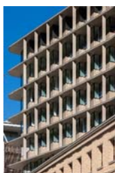
庇、縦ルーバー
