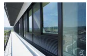
自然換気口（南面）
