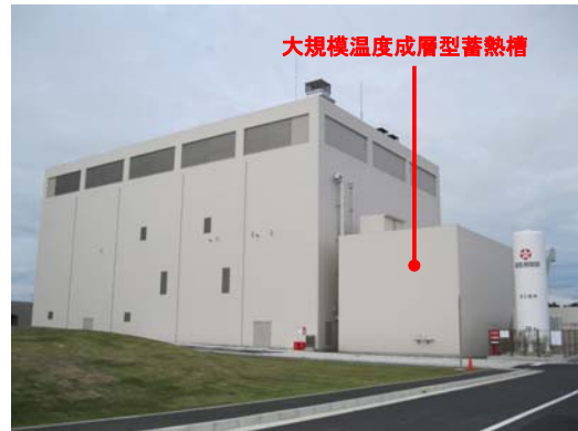
エネルギー棟と大規模温度成層型蓄熱槽
