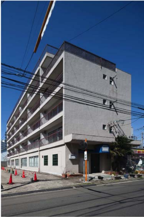
外断熱と内断熱の複数の断熱を併用・構造躯体を金属により保護 屋根面は外断熱防水,開口部は断熱サッシとLow-Eガラス
