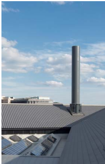
煙突全景と太陽光パネル
