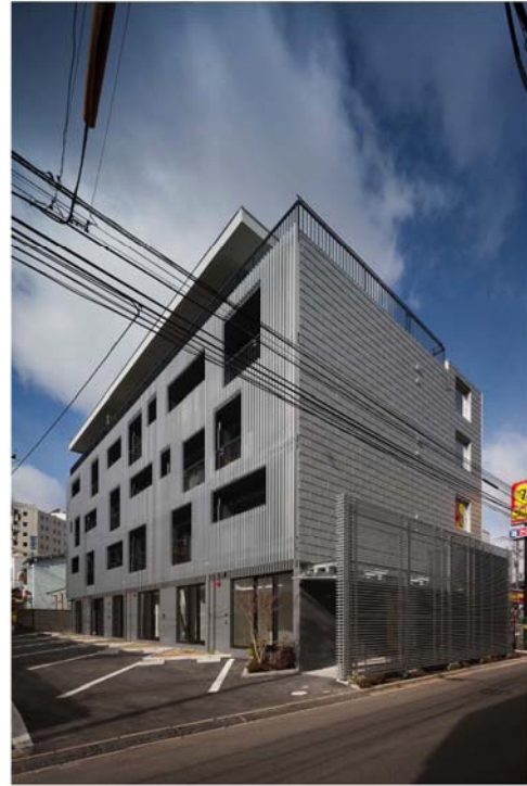
外断熱と内断熱の複数の断熱を併用・構造躯体を金属により保護 屋根面は外断熱防水,開口部は断熱サッシとLow-Eガラス
