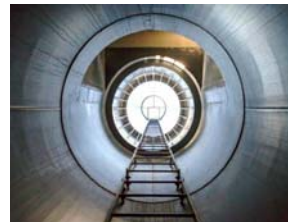
煙突内部見上げ
