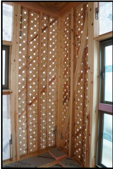
久万高原町が認定取得した間伐材利用のラティス耐震パネル
