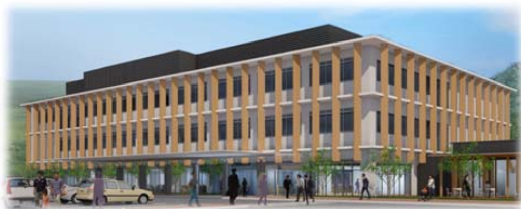
■木質ルーバー外観(北面)
