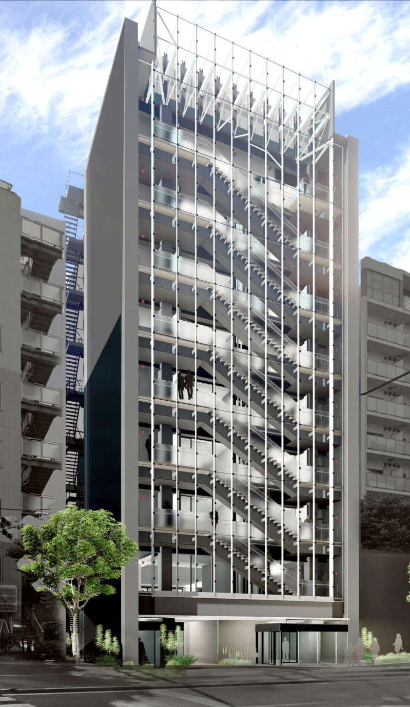
北面ファサード ～室内の活動を見せる～
