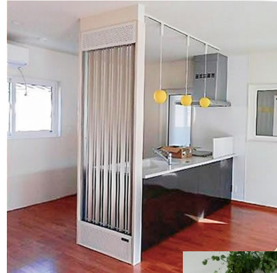
左:エアコン冷媒未利用熱方式の放射パネル設置例
