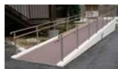
スロープの設置
