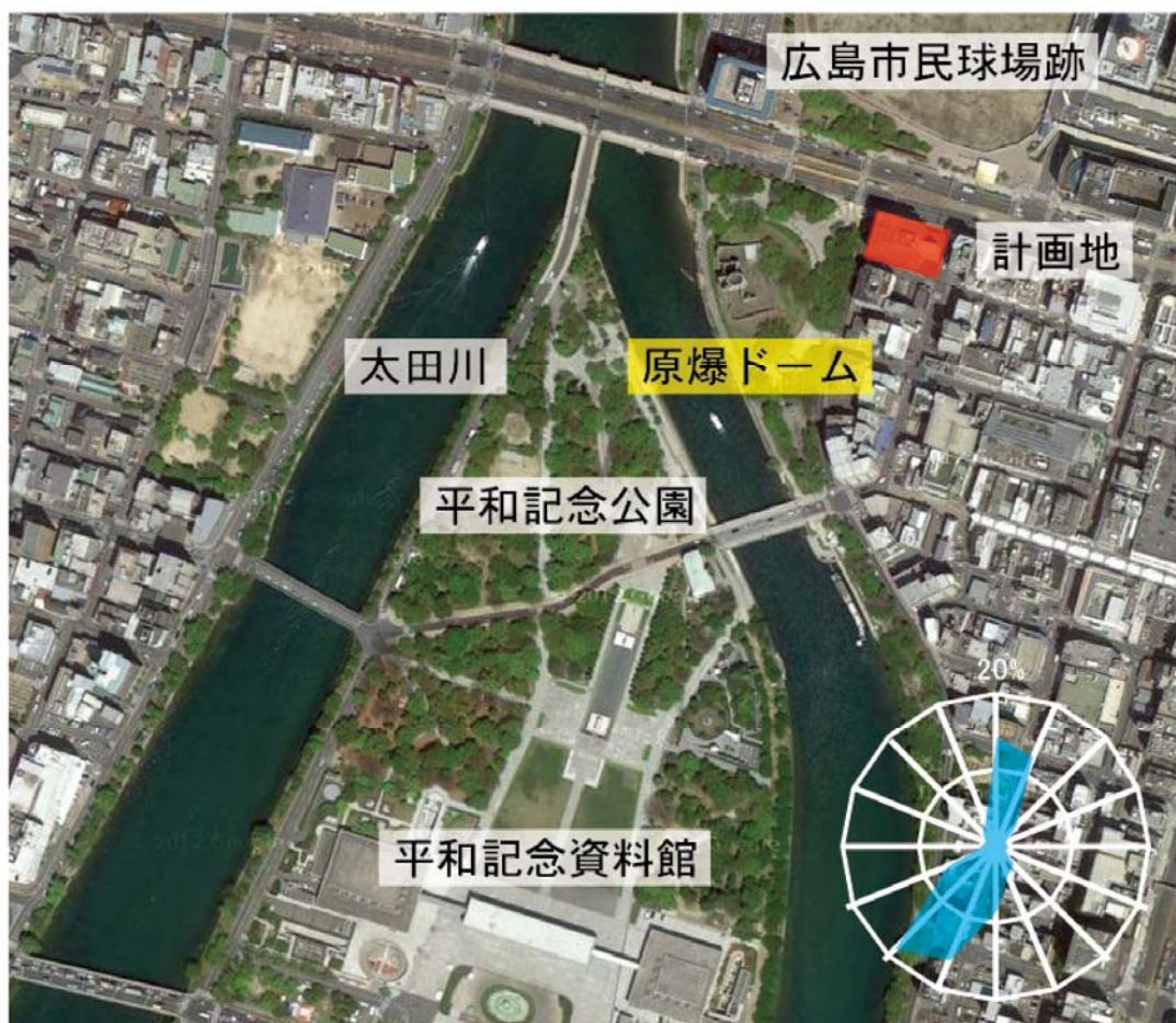
敷地周辺航空写真
