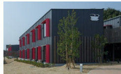
CLT工法による木造ホテル
